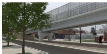
Vue vers l'ouest sur la rue Junction
