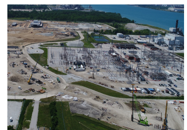
Fondations des travées du pont d'approche
