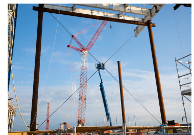
Coffrage temporaire pour la travée arrière
