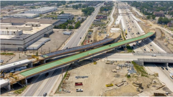
Construcción de rampas de la I-75 al Punto de entrada estadounidense
