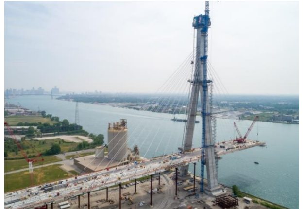
Emplazamiento de construcción del puente en Estados Unidos
