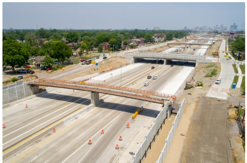
Construcción de caminos y puentes peatonales
