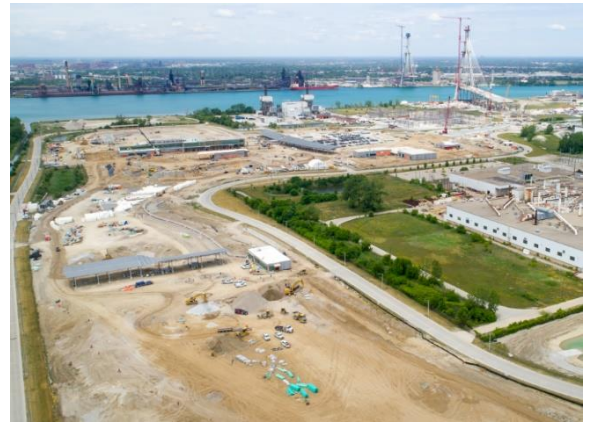
Construcción del Punto de entrada canadiense
