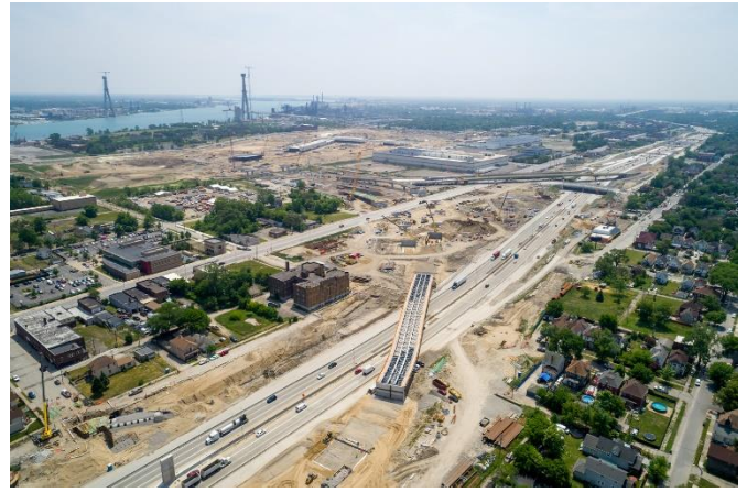
Construcción de la I-75.
