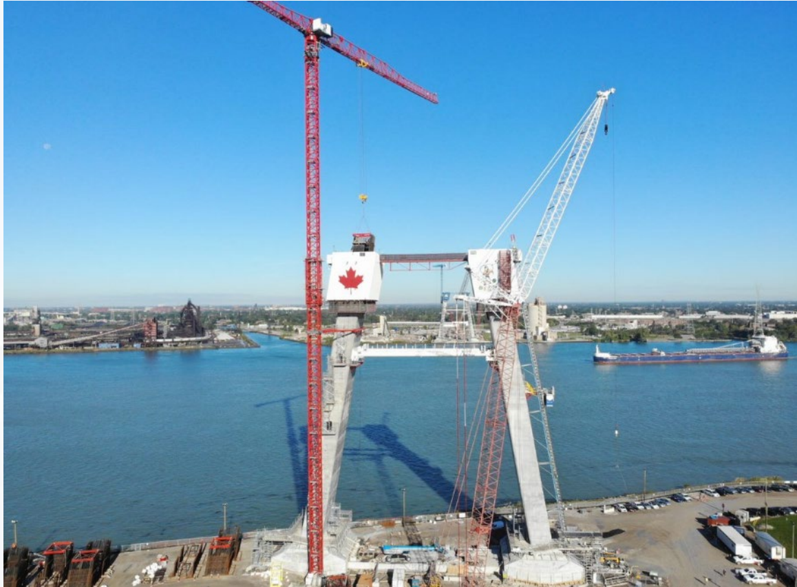
Travaux sur la tour du chantier du pont au Canada
