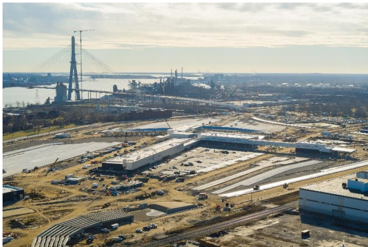
Construcción del Punto de entrada estadounidense
