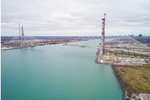
Avance de la construcción del puente
