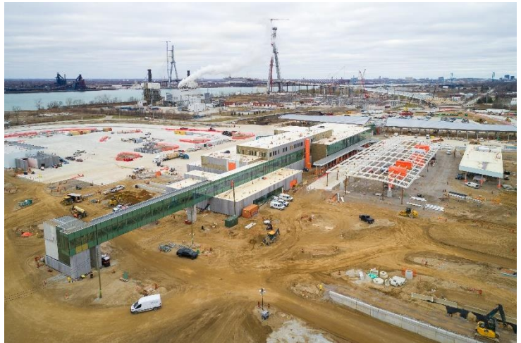
Construcción del Punto de entrada canadiense
