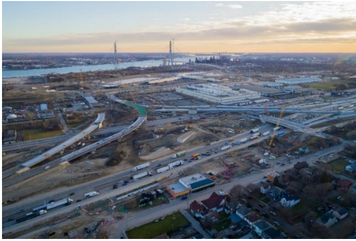
Construcción de rampas que conectan con la I-75 y el Punto de entrada estadounidense
