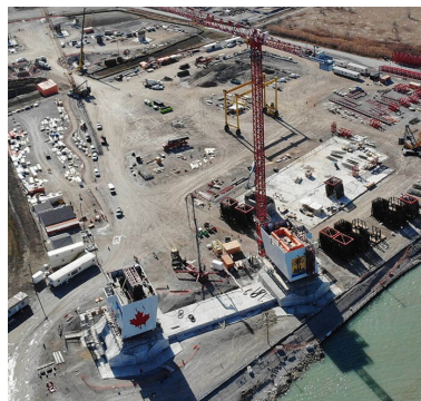
La construction se poursuit sur le chantier canadien du pont.
